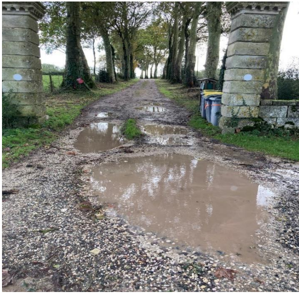
Cliché 1 – Entrée du chemin au bord duquel, sur son côté gauche, sera installée la réserve incendie.
